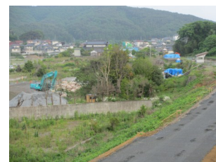
BRT専用線 細浦付近
